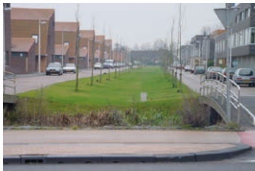
Bovengrondse infiltratievoorziening in leidsche Rijn, Utrecht
